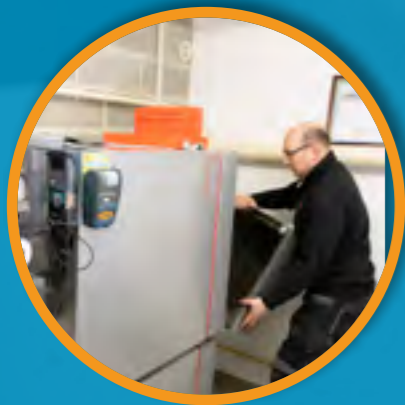
INSTALLATION DE CHAUDIÈRES GAZ, FIOUL ET GRANULÉS
